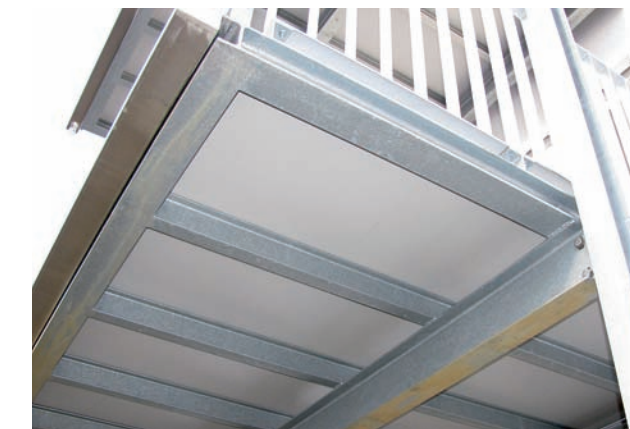
Subestructura vista del suelo del balcón
